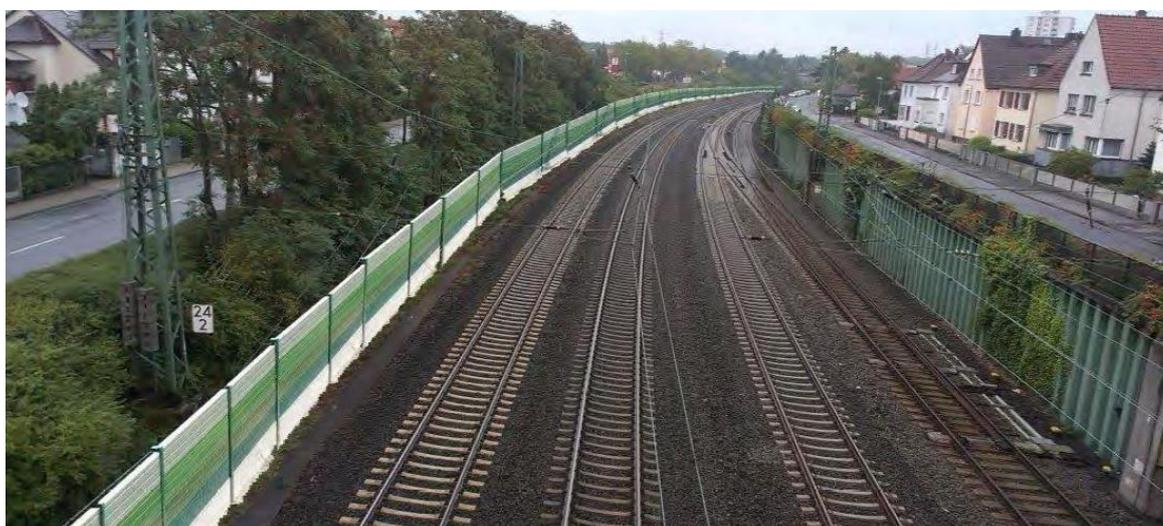
Foto: Beispiel für Lärmschutz entlang einer Haupteisenbahnstrecke
